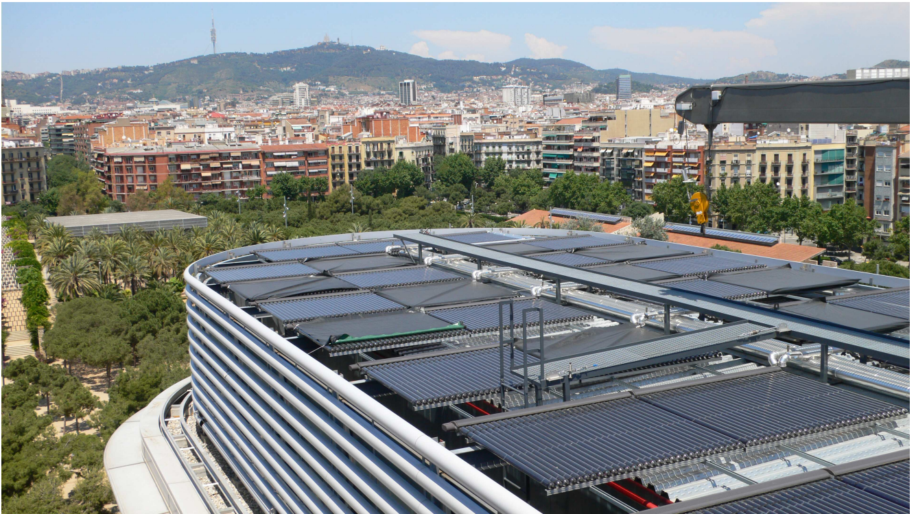
Illustration 14: Extrait galerie d'images commentées. Intégration de panneaux solaires thermiques sur les toits devant le parc Joan-Miró à Barcelone (Espagne). Crédits : J. Champres
