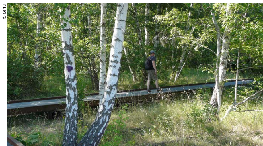
Illustration 16 : dans la zone protégée, les cheminements en caillebotis sont surélevés au dessus des anciennes voies
